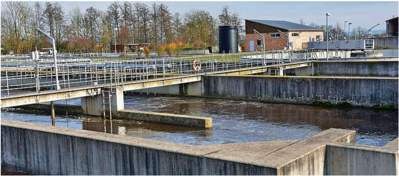
Die Kläranlage des Abwasserzweckverbands Pfattertal in Mintraching
