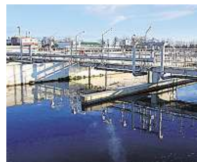
Dem hoch verschuldeten Abwasserzweckverband Pfattertal steht die nächste Klage ins Haus. Foto: MZ
