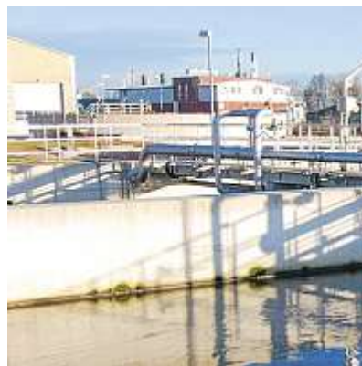
Die Kläranlage des AZV Pfattertal verursacht zu hohe Betriebskosten, sagt die BI. Foto: MZ-Archiv
