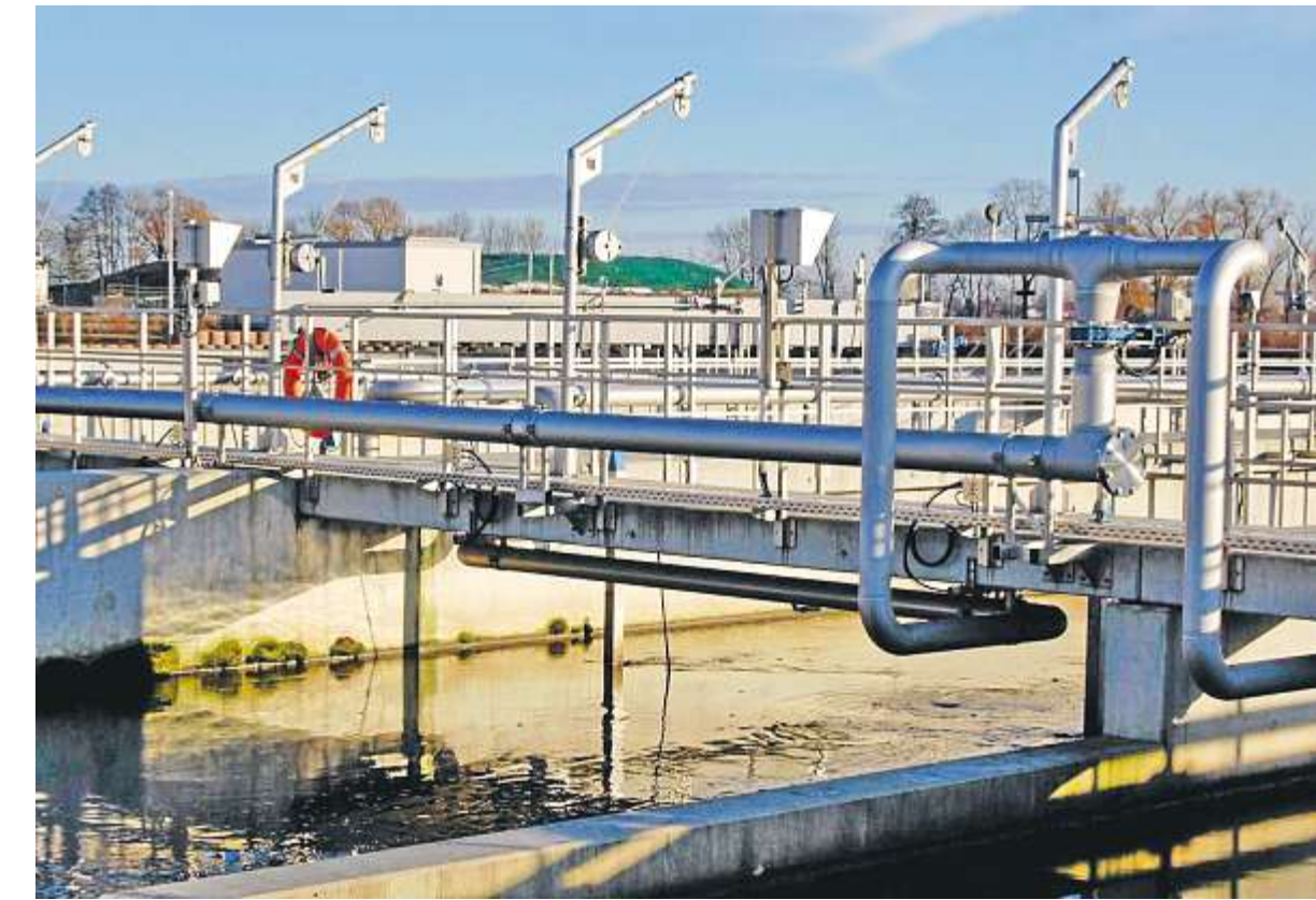
Falsch berechnet: Der Abwasserzweckverband Pfattal muss die Gebühren für die Jahre 2009/2010 neu berechnen. Dies geht aus dem Urteil des Verwaltungsgerichts Regensburg hervor.
