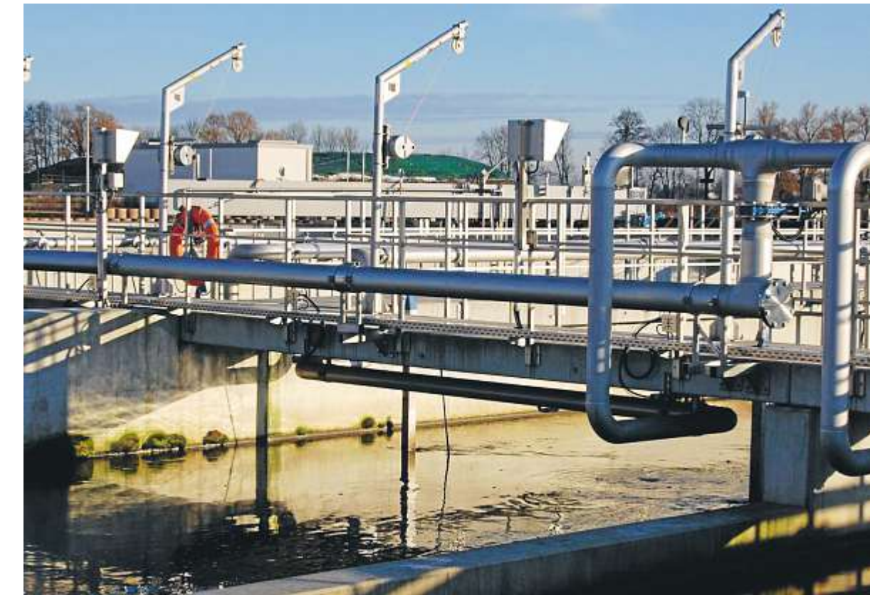
Nach wie vor ist unklar wann der Streit um die Kosten und Gebühren bei der Kläranlage des Abwasserzweckverbands Pfattal vor dem Regensburger Verwaltungsgericht verhandelt wird.
