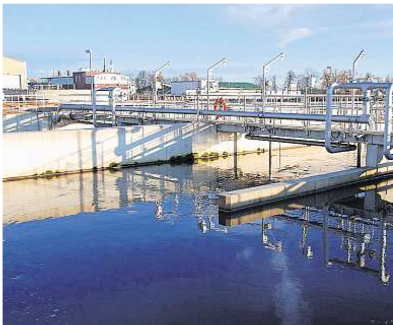
Die Kläranlage in Mintraching
